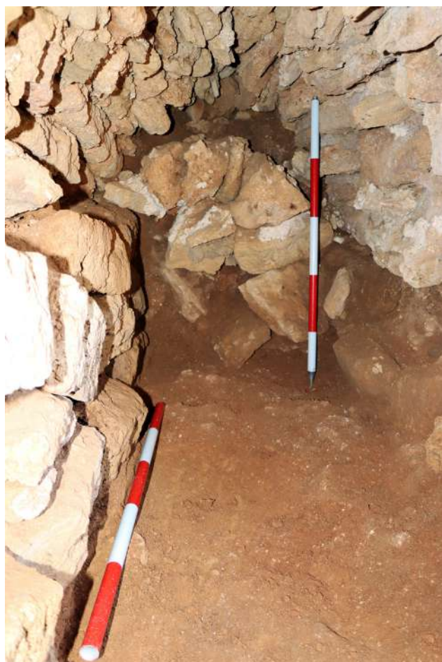
Sl. 4. Pogled na zidani svod iz unutrašnjosti grobnice ispod pregradnog zida južne prostorije nartekse (A. Alajbeg)
