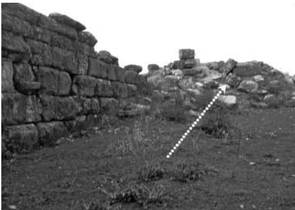
Dio megalitskog zida uz sjeveroistočnu kulu – obrušavanje elementa arhitektonske cjeline. Postepeno osipanje zidane strukture kule transformiralo ju je u amorfnu gomilu fragmenata koja više nema elemente arhitektonske čitljivosti. Sjeveroistočna kula, pogled od jugozapada.
