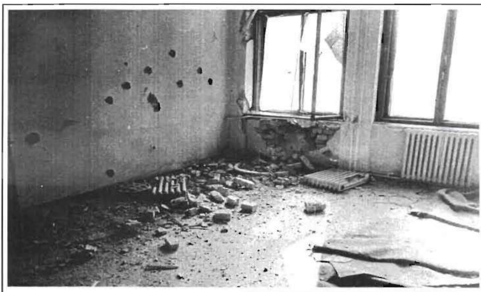
Havarisani kabinet direktora muzeja u zgradi Direkcije
