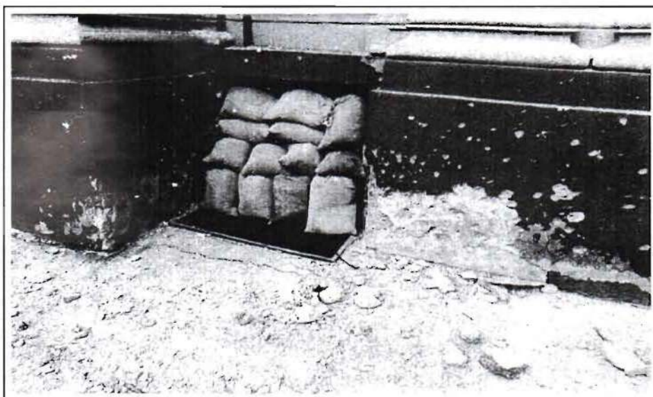
Prozorski otvori na podrumskim prostorijama zaštićeni su vrećama sa zemljom odmah nakon prvih granatiranja
