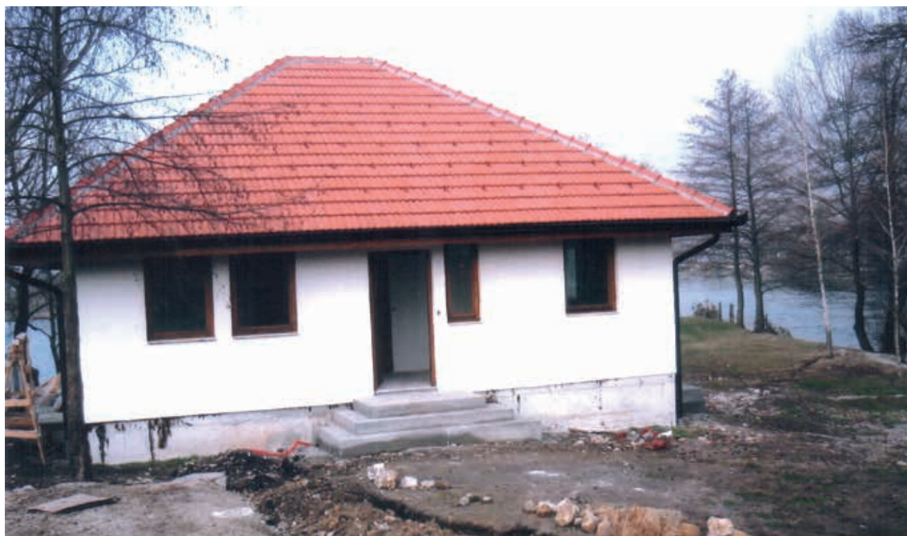
Sl. 4. Radovi na čestici 1417/1 prilikom provođenja infrastrukture (ustupio: H. Pašagić)
