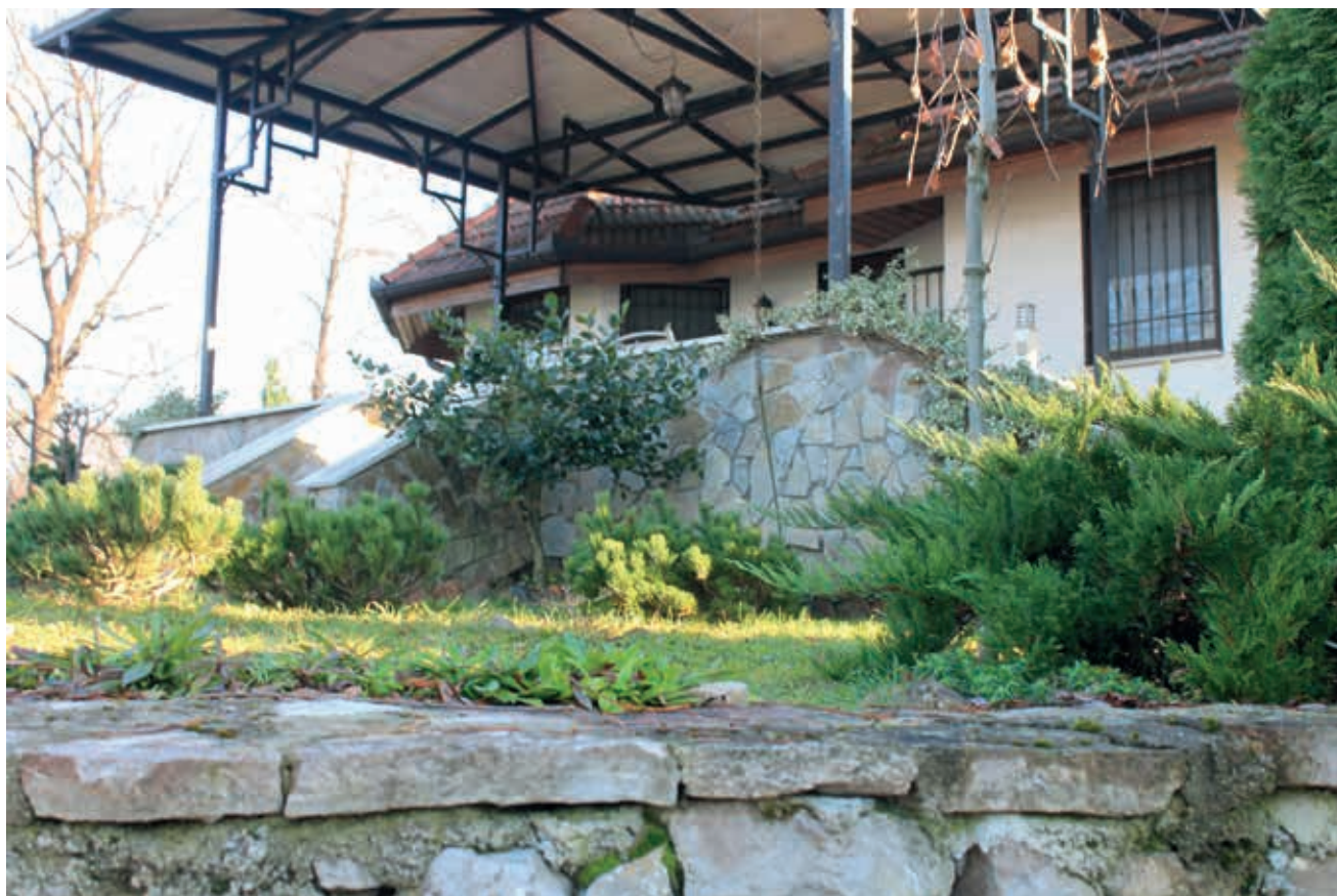
Sl. 3. Stambeni objekt izgrađen na čestici br. 1417/1 (snimio: J. Hadžihasanović 2015.)
