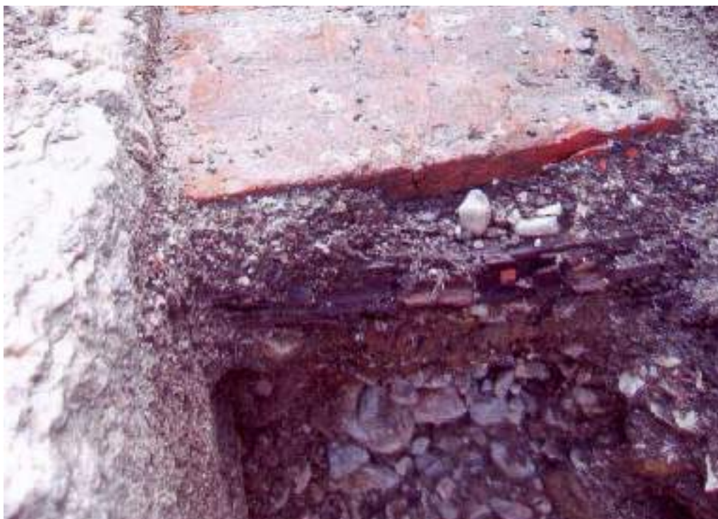
Sl. 07 Drvena podloga ispod popođenog poda uz sjeveroistočni zid Fig. 07 Wooden beams under paved floor by the north-east wall
